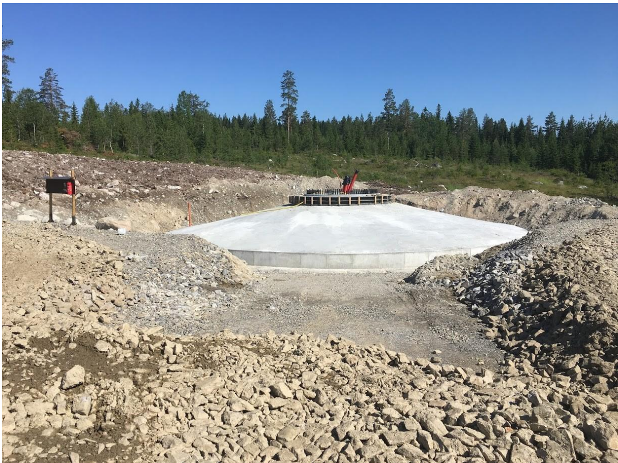
Figur 7. Gravitationsfundament i en av RWEs vindparker. Foto: RWE
