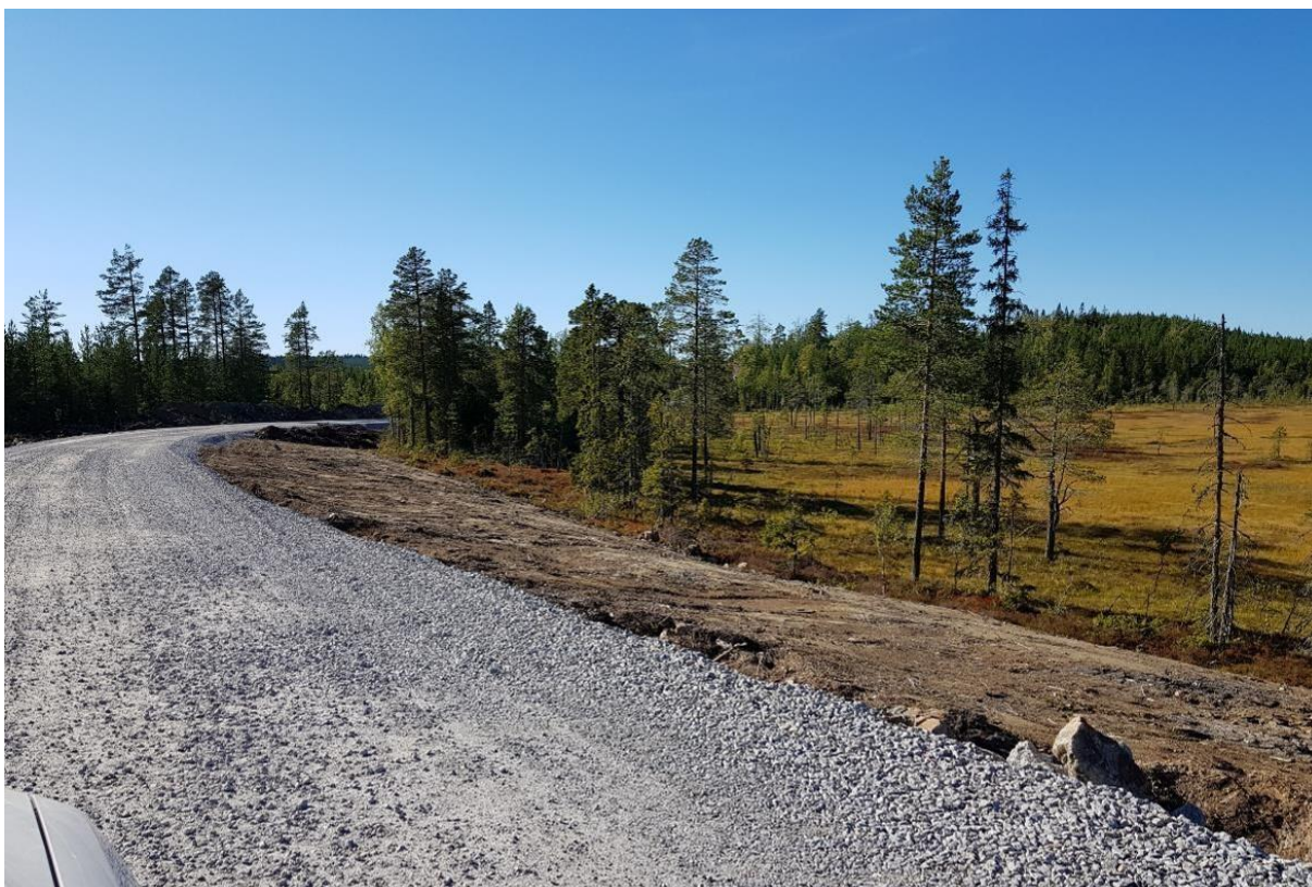
Figur 12. Nyetablerad väg vid en vindkraftpark. Foto: RWE
