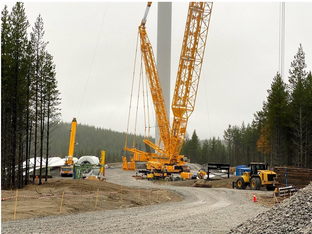
Figur 18. Montering av vindkraftverk. Foto: RWE
