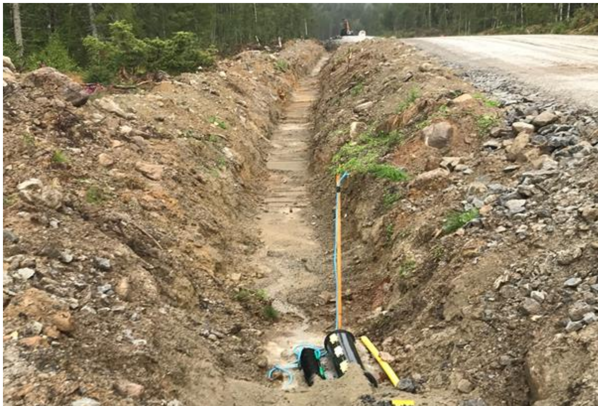
Figur 15. Kabelgrav med kabel och kommunikationsnät intill väg. Foto: RWE
