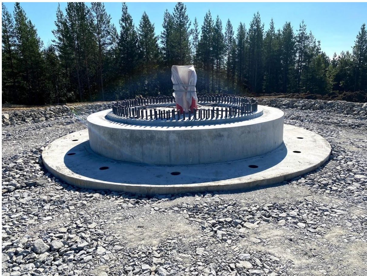
Figur 8. Bergförankrat fundament i en av RWEs vindkraftparker. Foto: RWE
